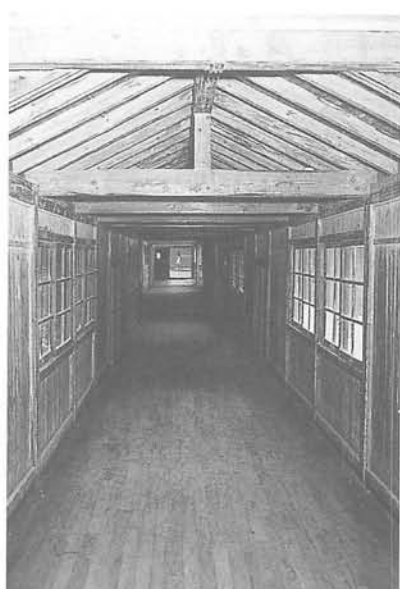
西側廊下 (旧体育館から新体育館へ)
